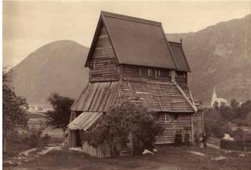
Stavkirke w Hopperstad w trakcie rekonstrukcji w 1885 r.: widoczne jest nowe pokrycie głównego dachu. W tle widać nowy kościół (RA) The stavkirke at Hopperstad under reconstruction in 1885: the new cover of the main roof visible. The new church can be seen in the background (RA)
